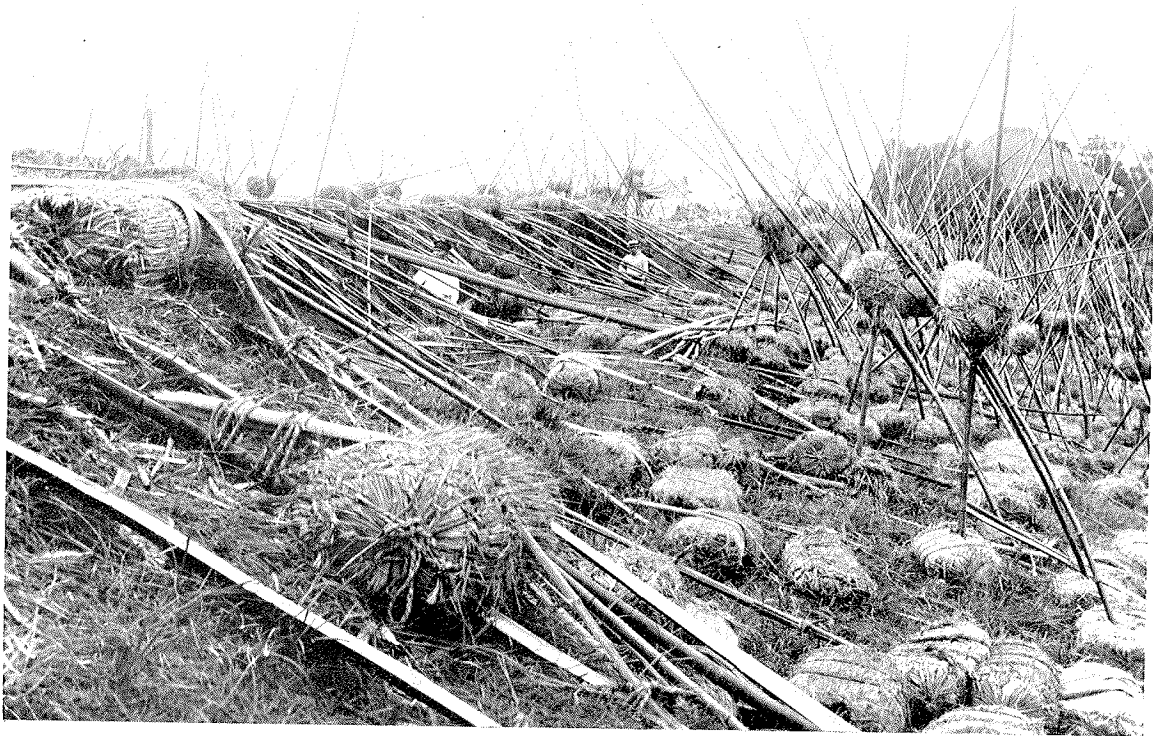
昭 和 十 年 洪 水 時 江 戶 川 堤 防 水 防
