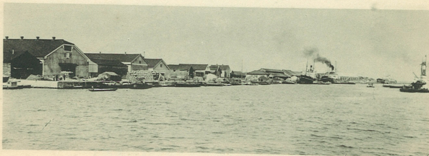
左岸第三號水深五米岸壁（伏木町新島）
