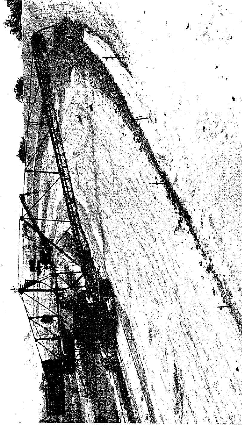
第 5 圖 主體上ノ水止メ粘土層及ソノ上置土層ハ圖ノ如キ土置き裝置ニヨツテ施工サレタ
