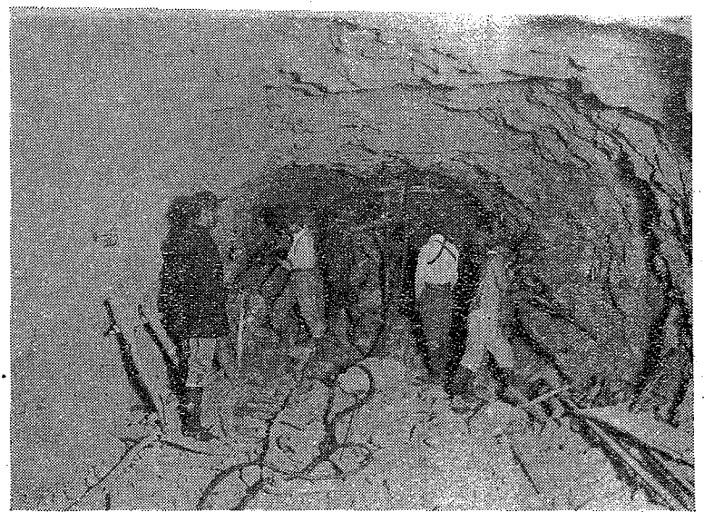
烏山嶺取入隧道中の工事 (掘削機にて坑内掘削作業)
