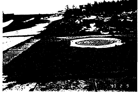
写真2 マンホール周辺地盤の沈下（熊谷町）
