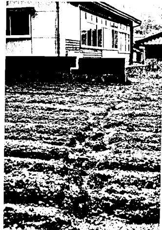
写真6 地盤の側方流動による畑地の亀裂と住家の被害（川浦町）
