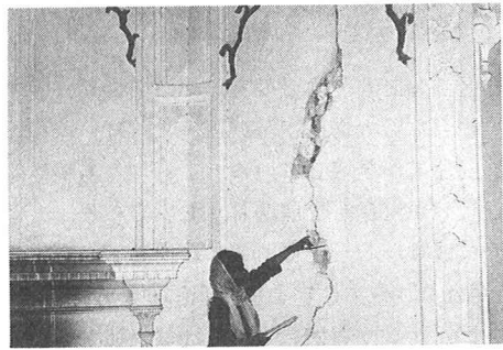
写真4 Chitralの旧王宮内モスクの壁クラック
