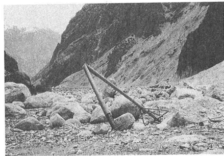
写真6 Gram Chashma方面での落石による電柱被害
