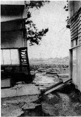
写真7 h-i 校舎渡り廊下
