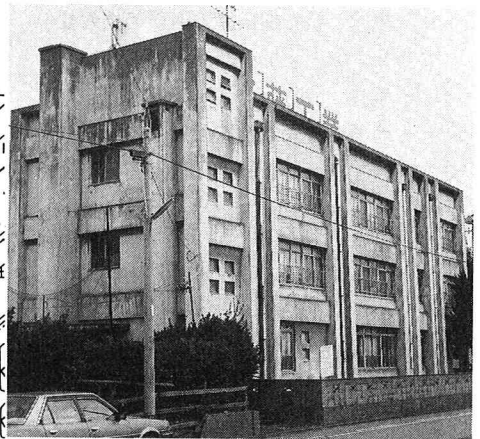
写真-1 調査建物全景
