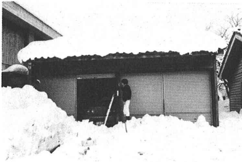
写真-1 工学部車庫A全景
