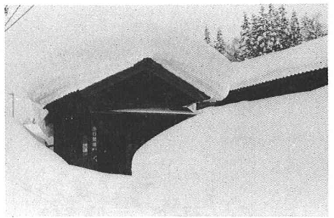
写真-2 白峰村小屋全景
