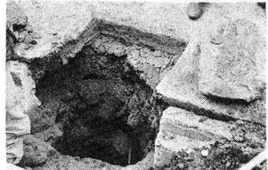
図-3 凍上時のソイルセメント上面(縁部)
