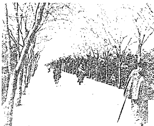
図一九 大正中期の新町住宅地東大通り桜並木 4)
