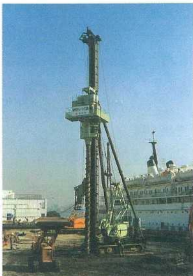
写真—3 晴海埠頭Lパースでの施工状況
