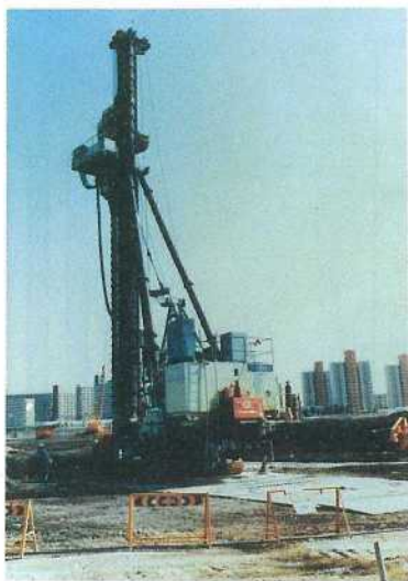
写真-1 江戸川第二終末処理場での施工状況
