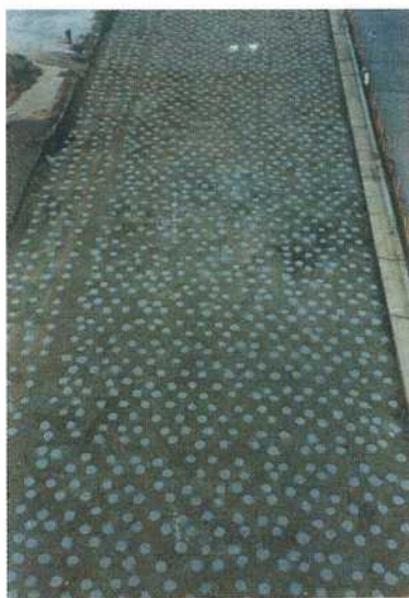
写真—4 打設後の砕石ドレーン杭
