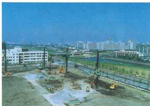
写真-2 コーシャハイムでの施工状況
