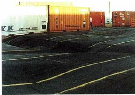
写真一27 マトソンターミナルの陥没 (オークランド港湾局提供)
