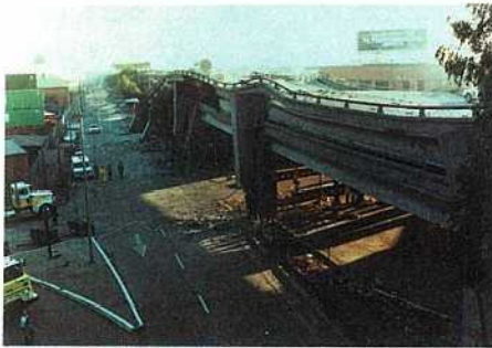
写真-6 サイプレス高架橋の被害状況 (32 番通り付近の崩壊状況で、右側が I-80 号線とのインターチェンジとなる。完全に上層の桁が下層の桁まで崩壊している。CALTRANS による)
