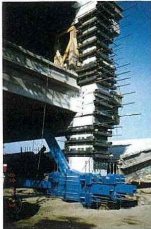
写真-20 試験補強された No. 47 の RC 柱 (京都大学工学部 竹脇 出氏提供)
