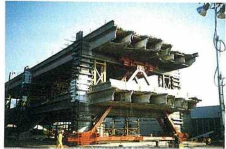
写真一十九 A型加力装置と試験補強されたNo.45および46のRC柱 (京都大学工学部 竹脇 出氏提供)
