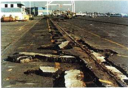
写真一26 ハワードターミナルの陸側のクレーンレール周辺の舗装被害と地盤沈下 (オークランド港湾局提供)
