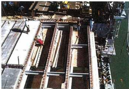
写真-4 復旧工事中の渡し桁 (E9 橋脚上)
