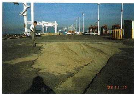
写真—24 7th Street ターミナルの液状化 (バース 37)
