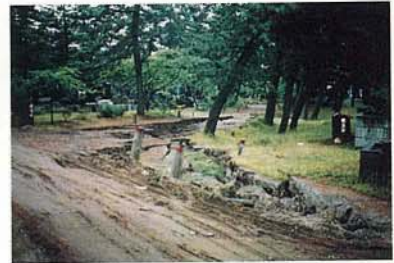
写真—2 能代市斎場(北部地域)における地盤変状の様子(森 芳信氏提供)
