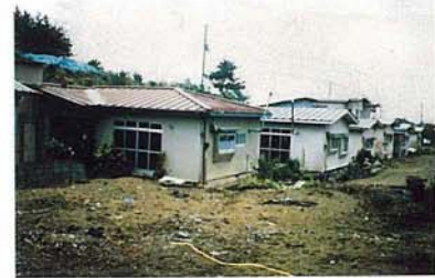
写真—3 前山北側(南部地域)の住宅地における地盤変状の様子(北東から撮影したもの。写真左が前山。森 芳信氏提供)
