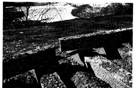
写真—6.2 Sylmer 地区レール破断
