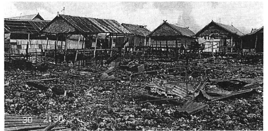
写真-2 被害を受けた高床式住居
