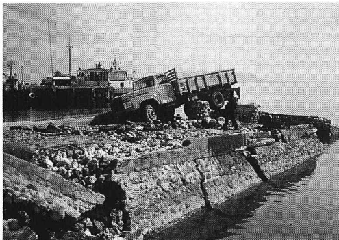
写真-2 マウメレ港の被災した埠頭と津波により流されたトラック
