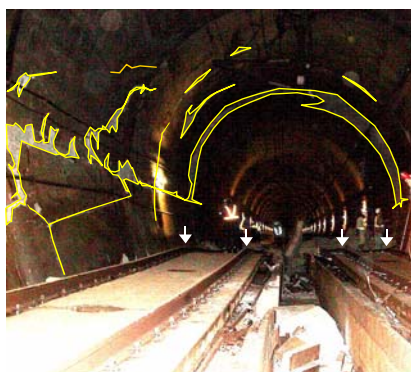
(a) トンネル被害箇所状況 （図-4(c)矢印）撮影：著者
