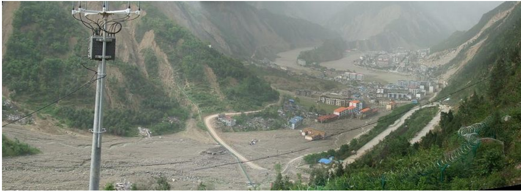
図-9 土石に埋もれた北川 (Beichuan) の街 (写真提供: 安田進, 撮影日 2009年4月20日)
