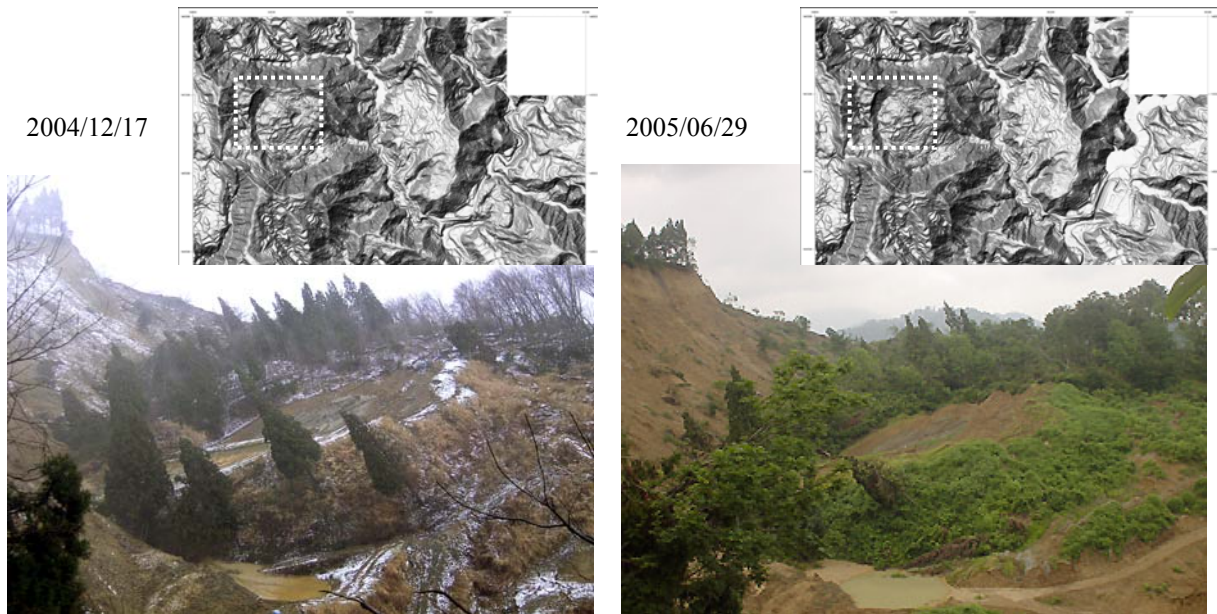
図-1 大日山の斜面崩壊（撮影場所 37.308673,138.888216）：2004 年中越地震で最大規模の崩壊である。降雪時期を挟んで撮影された 2 枚の写真でわずかながら変化が認められる。
