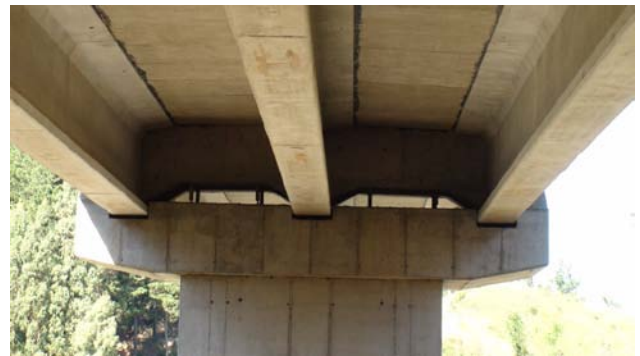
(b) Puerto de Lirquen 高架橋
