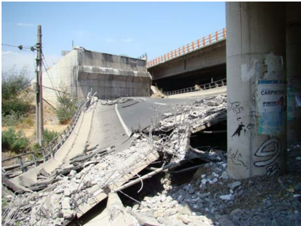
(a) 落橋した Hospital 橋の北行き車線側（斜角が 45 度）
