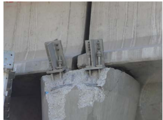
(b) Americo Vesputio / Av. Lo Echeveres 立体交差橋 （対面車線側の上り構造は落橋） 写真-4 分類Dの構造の例と被害
