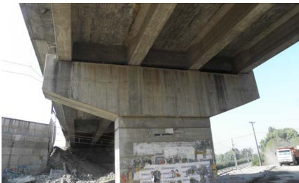
(a) Hospital 橋の南行き車線側のP C桁橋 (両端にせん断キー)
