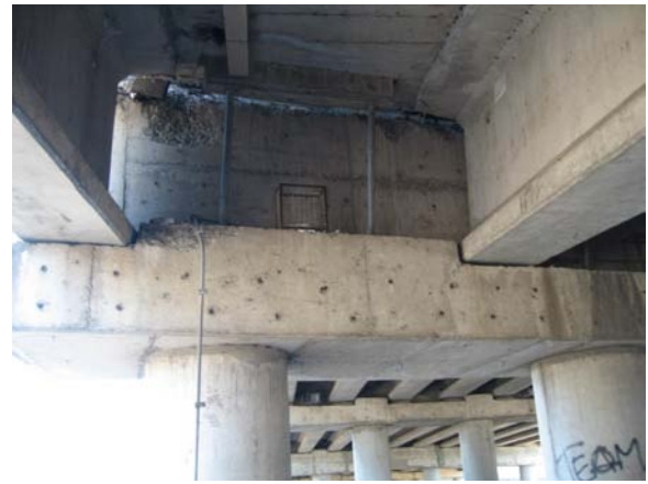
(a) キャップビーム上にせん断キーが見える（奥は落下した桁） (b) 落下した桁側のせん断キーと鉛直方向鉄筋 写真-2 分類Bの構造の橋の例と被害（Llacolen 橋へのアプローチ桁）
