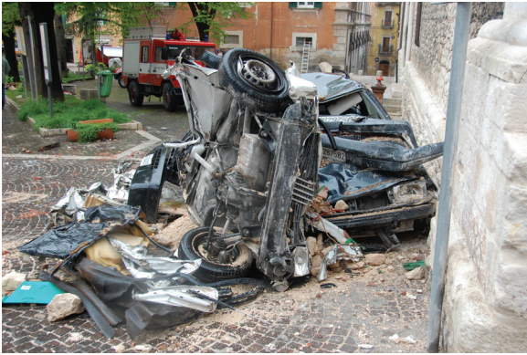
写真-18 建物の倒壊により埋没された車両（ラクイラ旧市街地）
