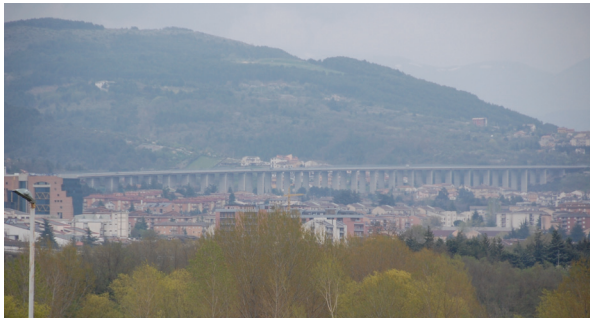
写真-8 ラクイラ市北部を横断するA24高架橋
