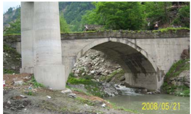
図-7 百花大橋下流にある石アーチ橋
