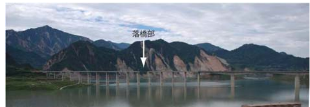
図-9(1) 廟子坪大橋
