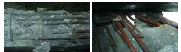
図-5 (4) リブ付根帯鉄筋
