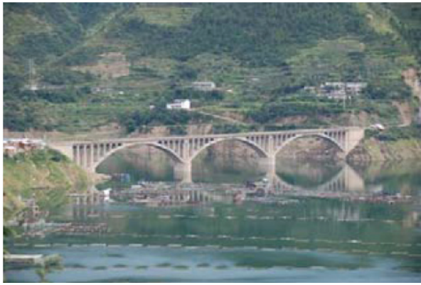
写真-9 白水大橋
