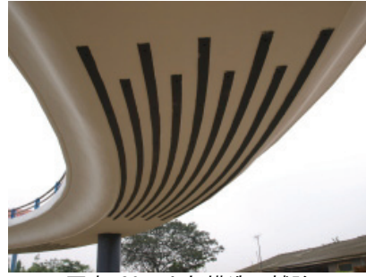
写真-20 上部構造の補強
