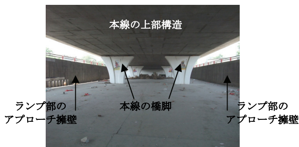
写真-13 本線部の橋梁の様子
