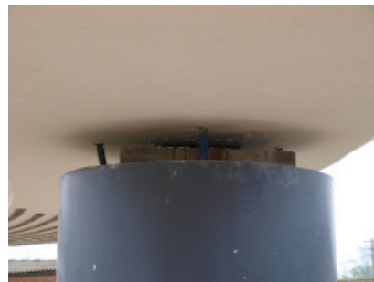
写真-22 新設された支承（支点条件の変更）
