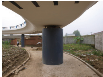
写真-21 円柱式橋脚の補強
