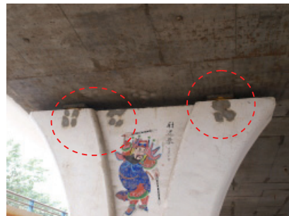
写真-24 本線部の補強後の様子
