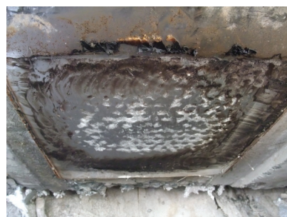
写真-17 橋台部のソールプレートの痕跡
