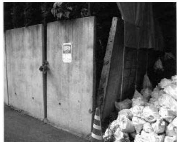
写真-1 宅地擁壁の被災度判定状況 (判定結果ステッカー表示)
