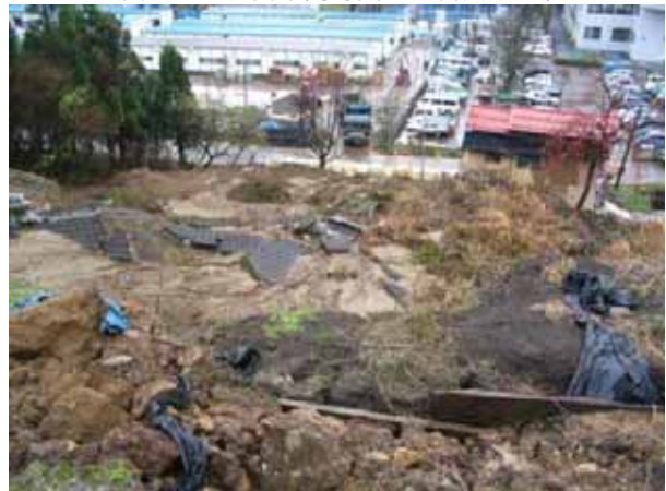
写真-10 小千谷市船越団地の斜面崩壊状況
