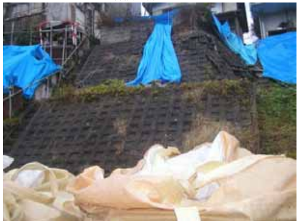
写真 - 3 二段擁壁の上にさらにコンクリートブロックを増積みした擁壁
