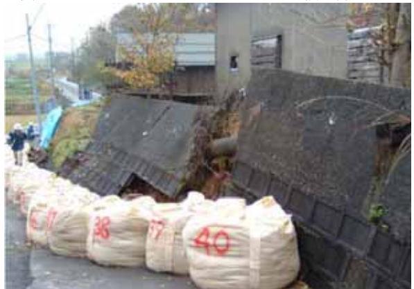
写真 - 2 元の擁壁の上にコンクリート壁を設置し、盛土をした増積み擁壁
