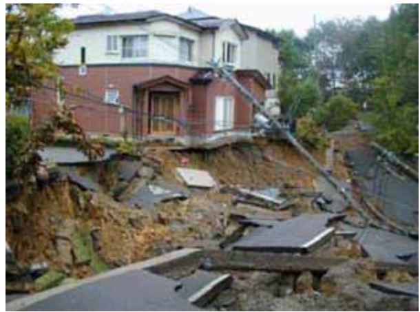
写真-9 長岡市高町団地の斜面崩壊状況
