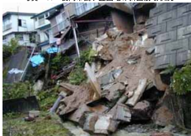
写真-12 小千谷市内の河川斜面崩壊状況
