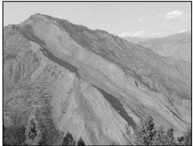
写真 19 チャカールの巨大地すべり
