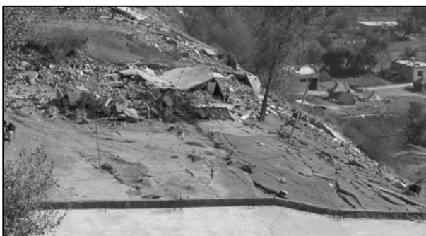
写真 14 斜面上に生じた亀裂
