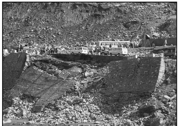
写真 9 擁壁の崩壊
