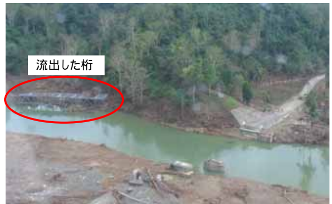
写真 - 10 流出した桁(Phot by UN)
