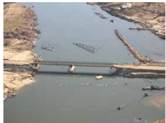
写真 - 9 流失した橋梁 (Phot by UN)
