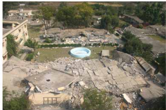
(b) ノン・エンジニアード建物の被災例(a1,b1,c1タイプ)
