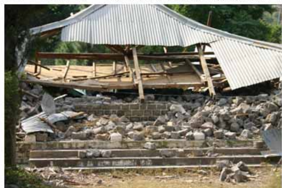
(c) ノン・エンジニアード建物の被災例(a2,b1,c1タイプ)
