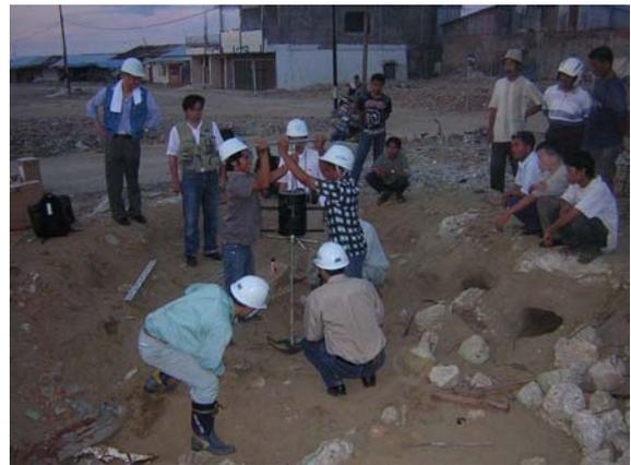
写真-4 Gunung Sitoliで暗くなるまで行なわれたスウェーデン式サウンディングの現地講習(被害を受けた建物はすべて撤去されて更地になっている)
