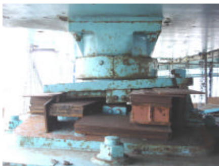
写真 3 応急復旧後の支承部
