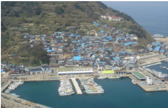
写真 - 6 玄界島における被災家屋
