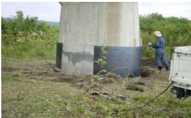
写真7 千代田大橋鋼板接着補強
