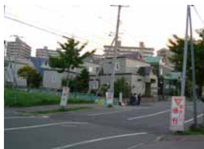
写真 4 札幌市清田区における住宅の不同沈下
