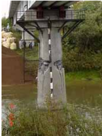
写真 1 浦幌川橋梁橋脚
