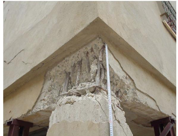
写真-2 梁・柱接合部の損傷
