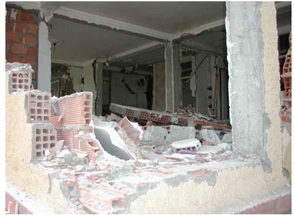
写真-1 レンガ壁の崩壊
