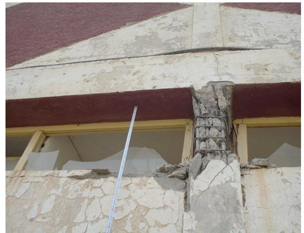
写真-3 短柱のせん断破壊
