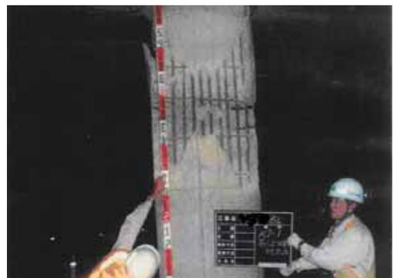
架橋の構造自体の問題に加え、後述するように損傷区間は北上川に沿った相対的に震度の大きい地域にあり、入力地震動との関係からもその損傷メカニズムの解明が必要と考えられる。
