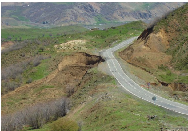
写真-1：ハイウェイにおける斜面崩壊
