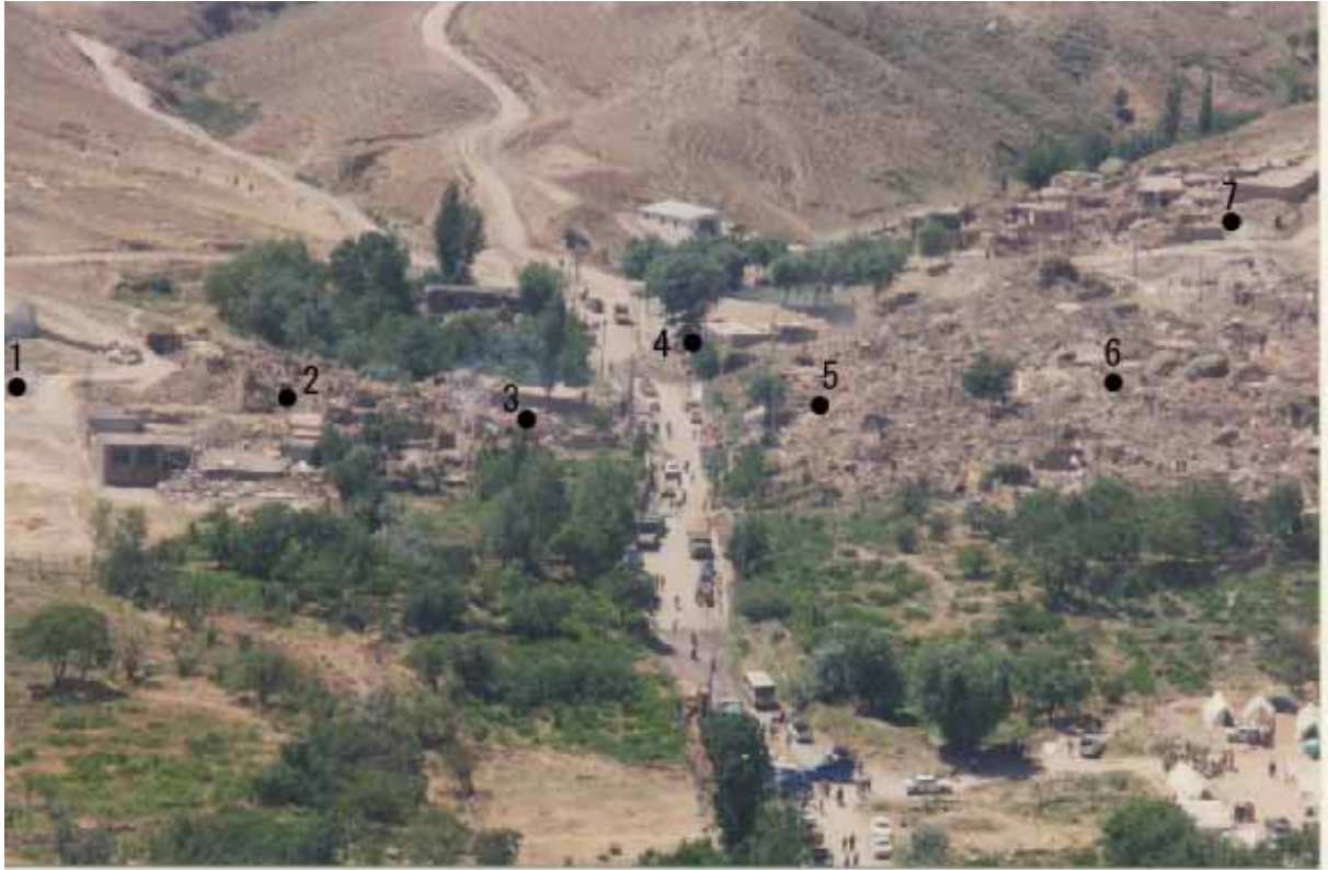
写真-1 アブダレ村の被害状況と常時微動観測位置
