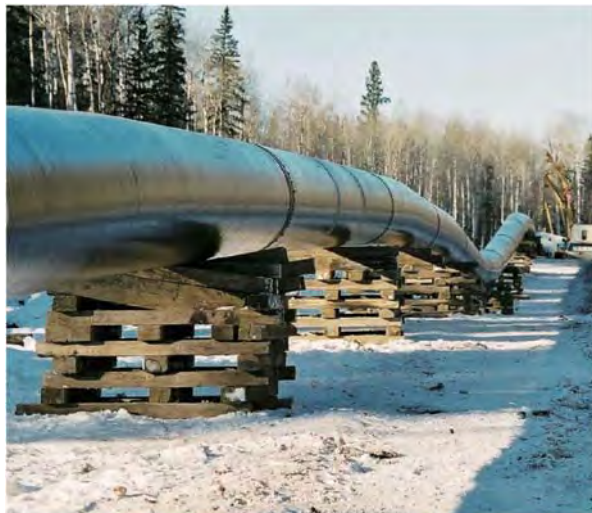
写真-6.4.1 ラインパイプの敷設工事の例(最終的にはパイプは埋設される) 40)
