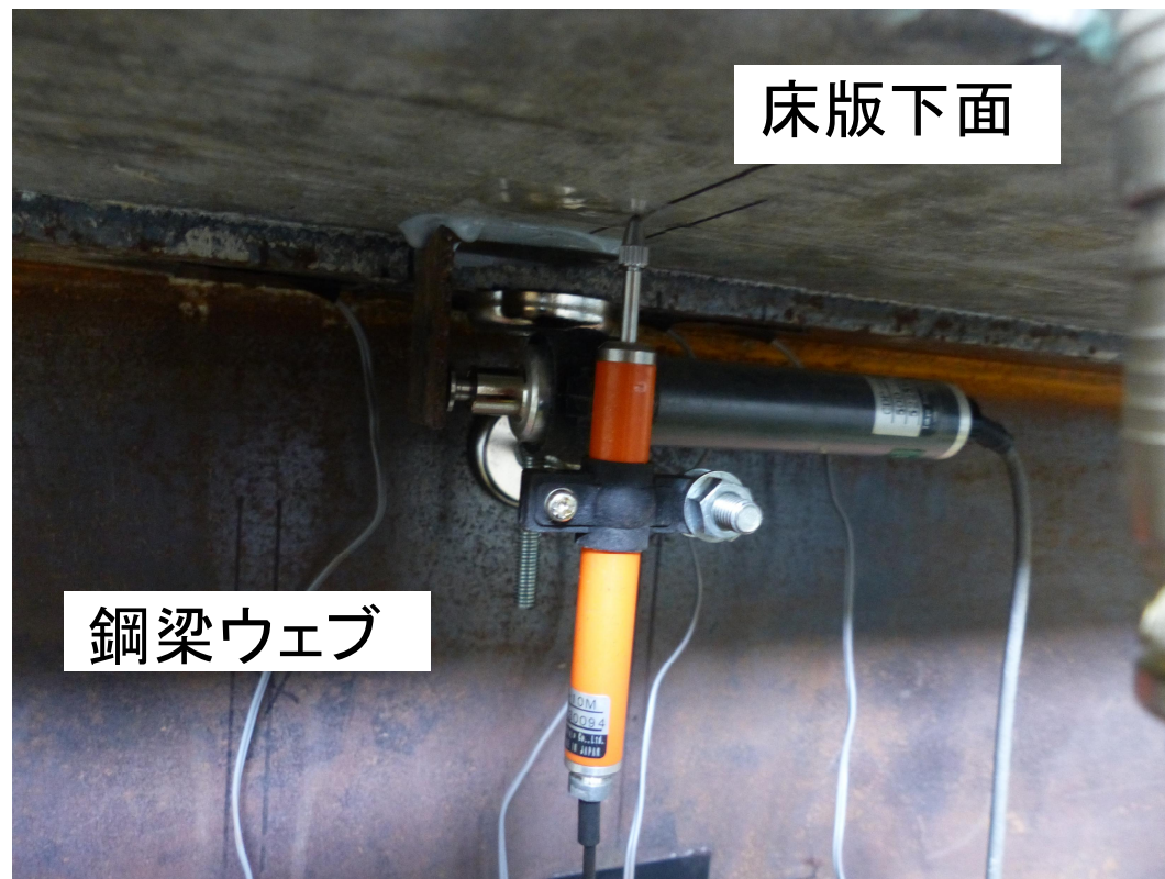
床版と鋼フランジの開き変位計測
