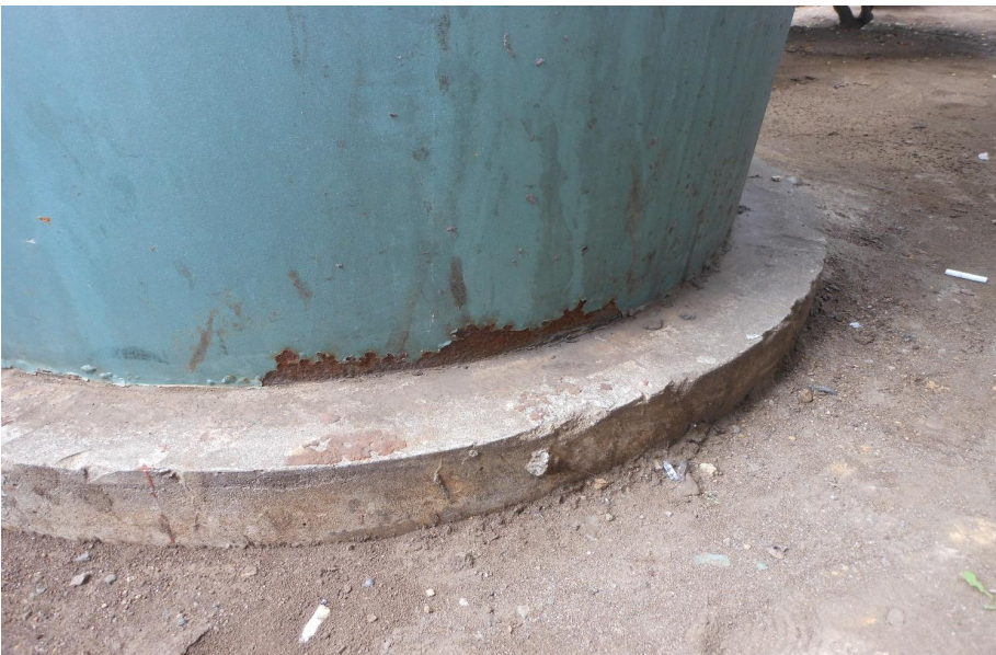
東京駅中央線を支持する鋼製橋脚
