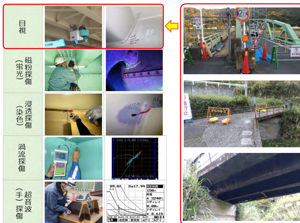
図-3.6.5 鋼橋の非破壊検査 (3.6.2)
