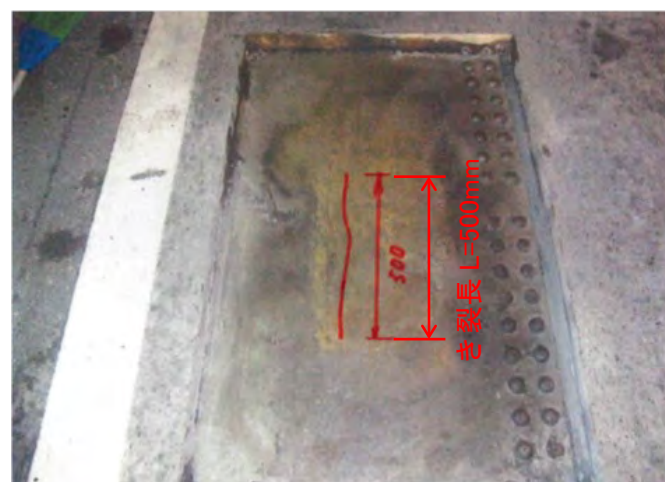
図-3.4.5 鋼床版検査装置による検査結果の分析事例 (3.4.2)
