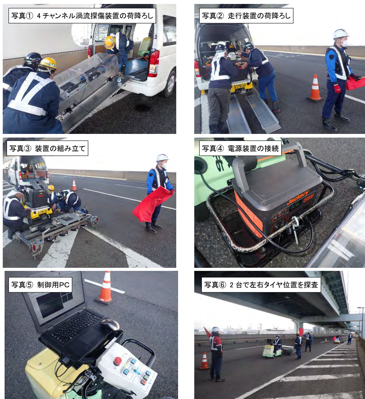
図-3.4.4 現場作業フローとセッティング状況
