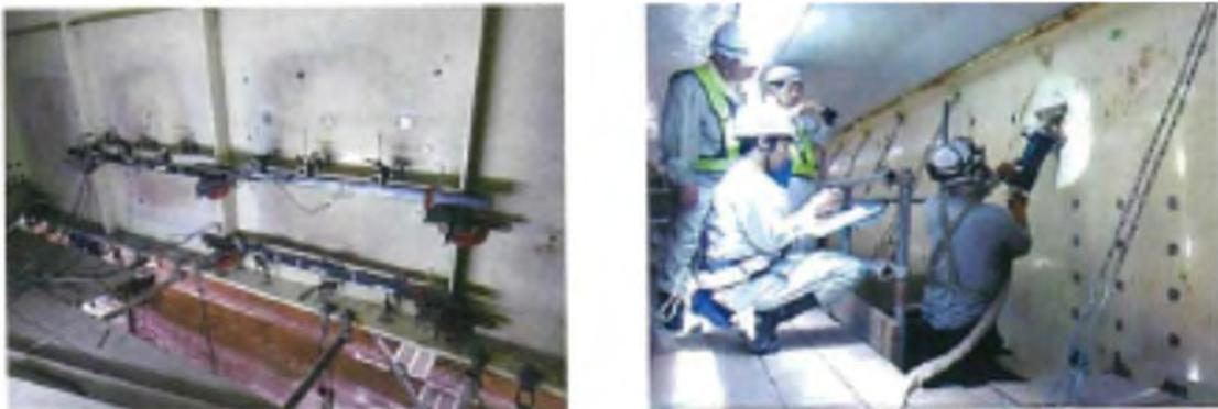
図-5.2.2 プレートガーダーウェブの加熱および面外変形の計測[5.4]
