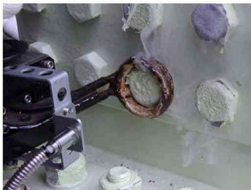
図-4.2.3 ボルト専用IH装置[4.8]
