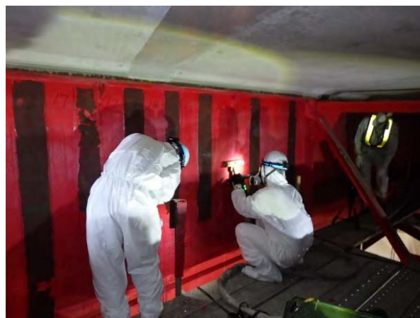
(c) 施工状況
