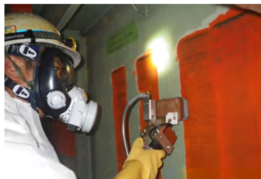
(e) 施工状況
