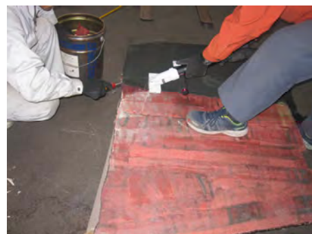
(e) 施工状況
