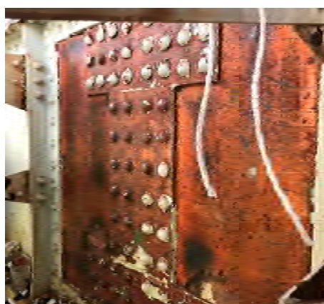
(e) 施工状況
