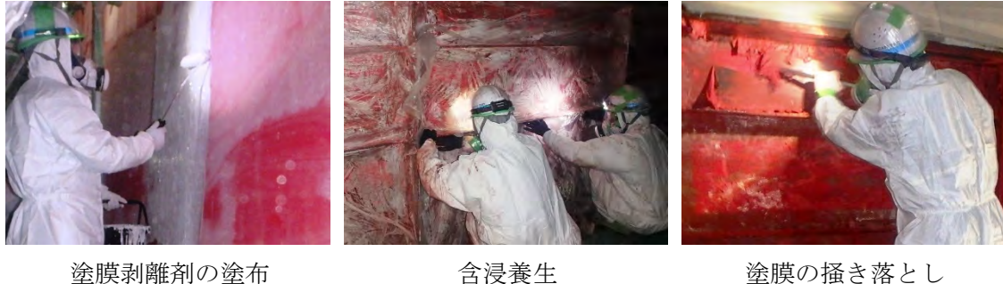
図-2.3.5 塗膜剥離剤の施工例
