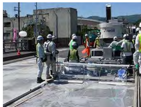
写真-2 UHPFRC による床版補修事例
