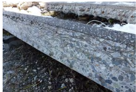
写真-1 床版コンクリートの層状ひび割れ発生事例
