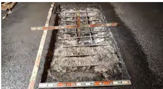
写真-6 補修時の床版上面状況 (2017年)
