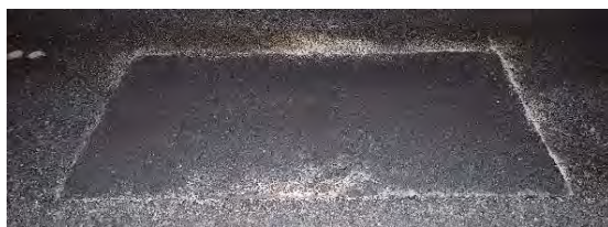
写真-7 補修後の泥の噴出状況 (2019年)
