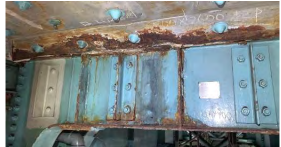
写真-3 ハンチ部補強鋼板の腐食状況
