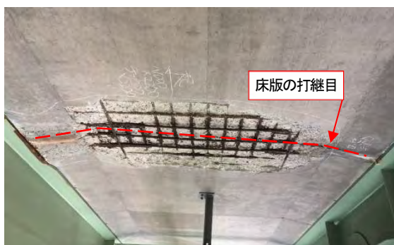
写真-8 はく離・鉄筋露出状況の一例
