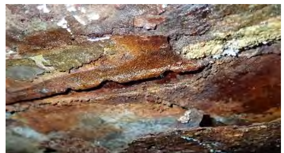
写真-2 腐食箇所における断面欠損状況
