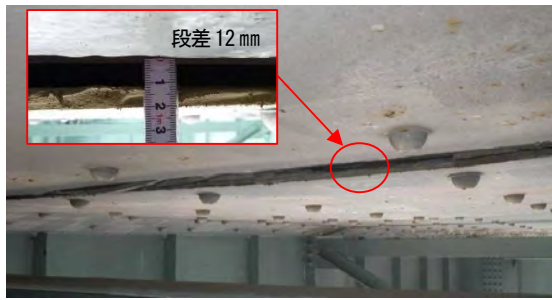
写真-4 補強鋼板のはく離状況
