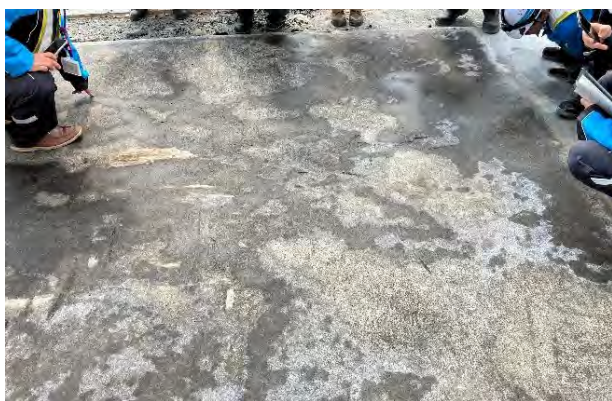
写真-3 舗装撤去表面状況
