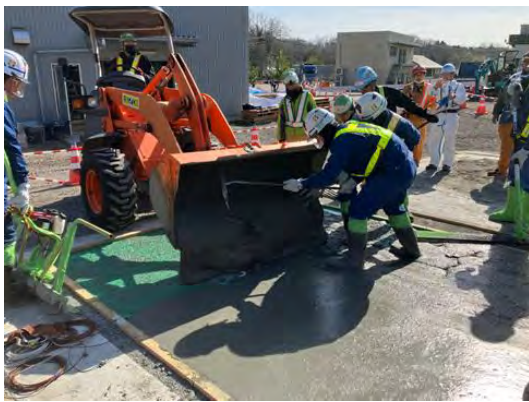
写真-1 UHPFRC 施工状況
