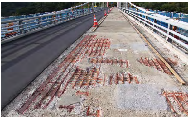
写真-3 はつりとウォータージェット施工後の状況
