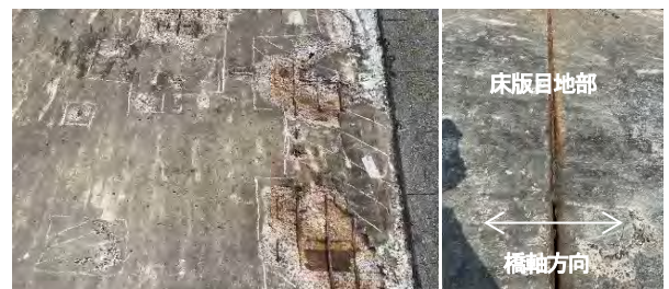
(a) 土砂化部と鉄筋の腐食
