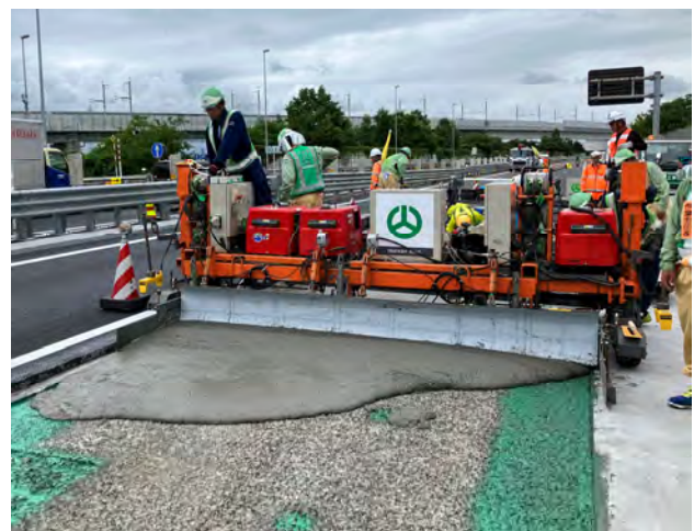
写真-9 フィニッシャー打設状況
