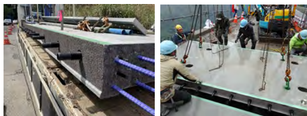
図-10 橋軸方向の接合
